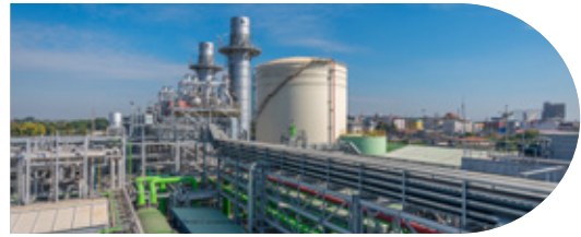
POWER GENERATION E TRATTAMENTO ACQUA
